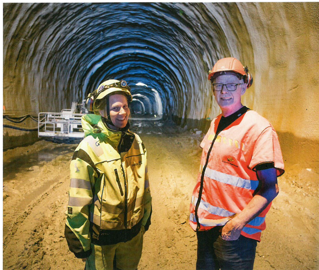
LØSMASSE/FJELL: 100 meter inne i tunnelen går det fra å være en løsmassetunnel til en tradisjonell tunnel i fjell. Ingeniørgeolog Margrete Øie Langåker og prosjektleder Lars Magnar Røneid synes prosjektet har vært spennende å jobbe med.
