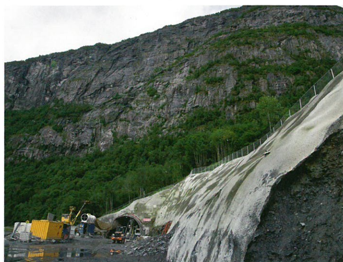
HØYT: Det er både høye fjell og høye skjæringer inn mot den nye Jobergtunnelen.
