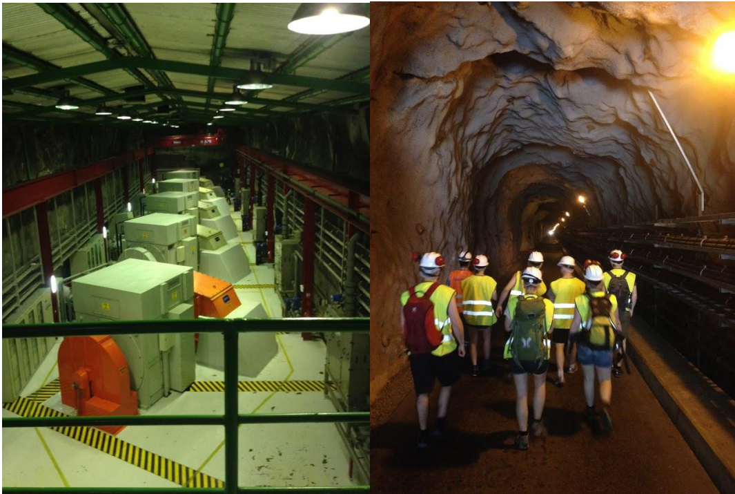
Kraftverkshall og studenter på veg inn adkomsttunnel i Khimti-prosjektet.
