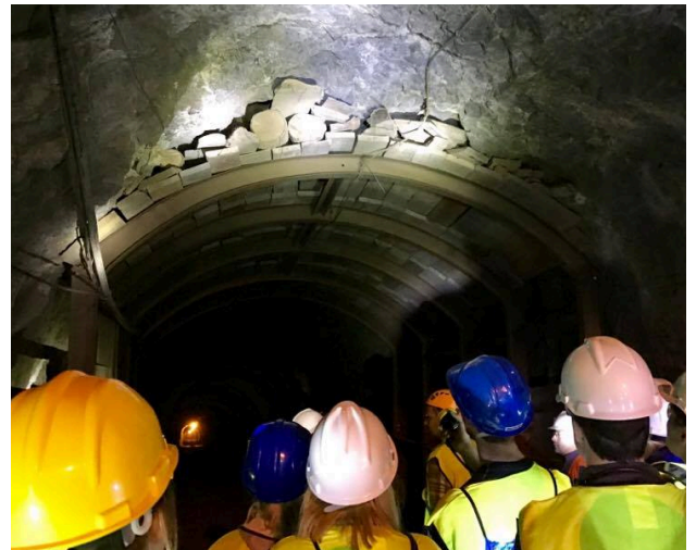
Sikringstiltak i gruva
