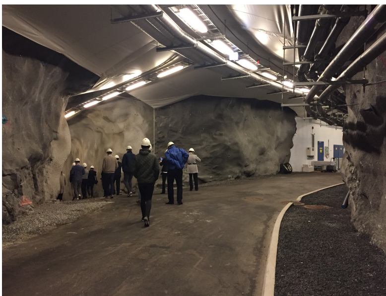
Sikringstiltak: Joakim har lokalisert stålfiberarmert sprøytebetong.
