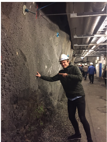
Sikringstiltak: Joakim har lokalisert stålfiberarmert sprøytebetong.
